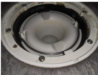
Tettesjiktets tilslutning til sluk - Sluk
