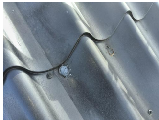
Tekking (med tilhørende beslag) - Hull etter tidligere innfestning
