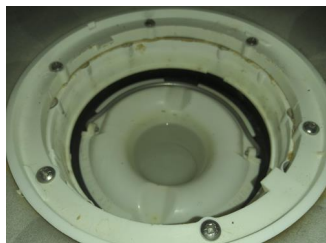
Tettesjiktets tilslutning til sluk - Sluk
