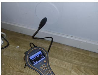
Kontroll i lukkede konstruksjoner - Fuktmåling
