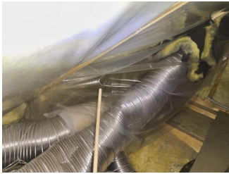
Konstruksjonsoppbygging - Løs damspærre i kneloft
