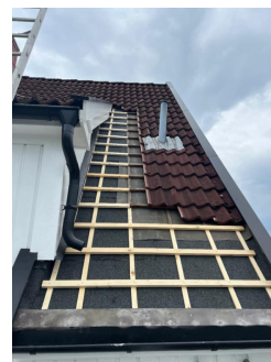
Det er ikke tilfredsstillende tetting/beslagsløsning ved hjørnekasse mot taktekkning. Det er åpninger i overgangen som kan medføre at nedbør og fukt trenger inn i underliggende konstruksjoner.
