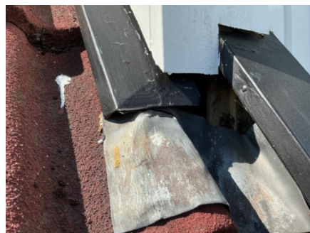
Det er ikke tilfredsstillende tetting/beslagsløsning ved hjørnekasse mot taktekkning. Det er åpninger i overgangen som kan medføre at nedbør og fukt trenger inn i underliggende konstruksjoner.
