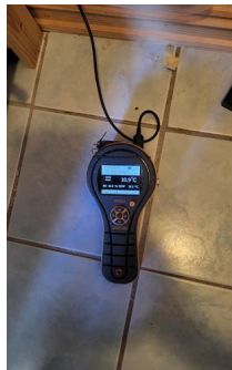
Utført kontroll i tilliggende konstruksjon - Fuktmåling
