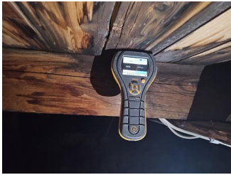
Synlige overflater (taktro, vegger, gulv, o.l) - Fuktmåling med pigge i treverk ved bjelkelag ved takluke.
