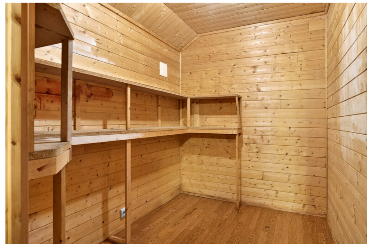
Innvendig bod på innsiden av vaskerom.
