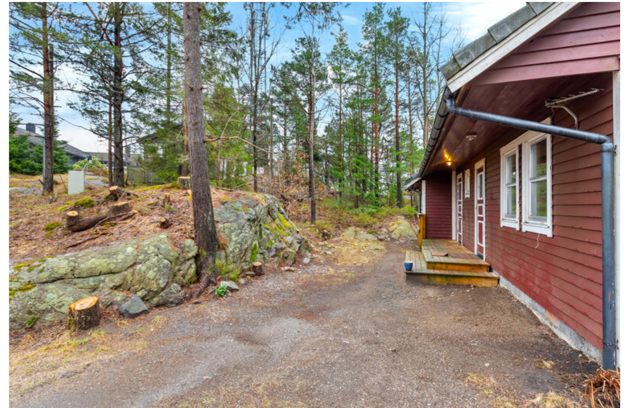
Inngangsparti med hovedinngang og inngang til vaskerom.
