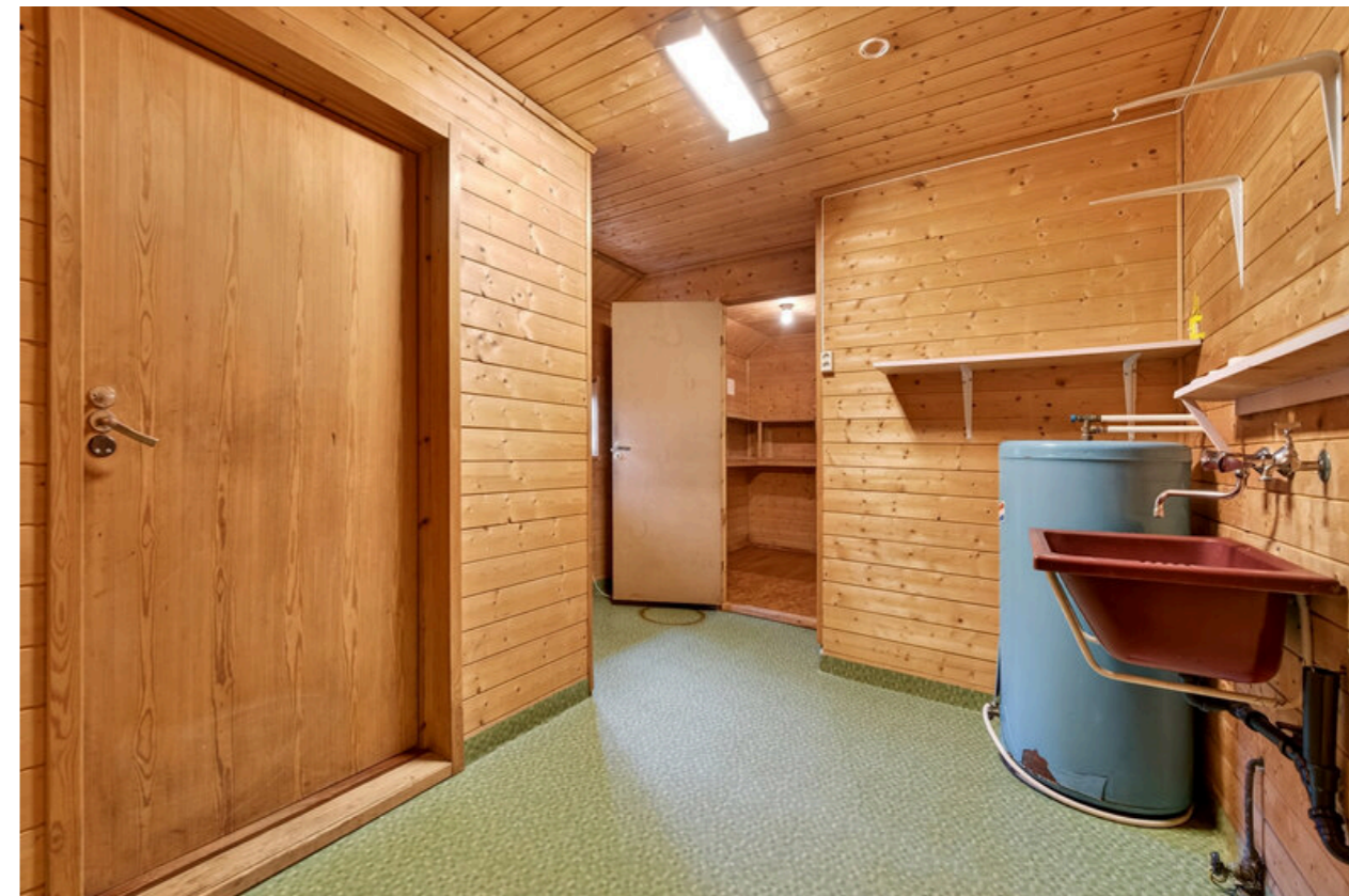
Vaskerom av eldre dato med utslagsvask, varmtvannsbereder og opplegg for vaskemaskin.
