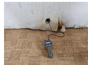
Utført kontroll i tilliggende konstruksjon - Fuktmåling
