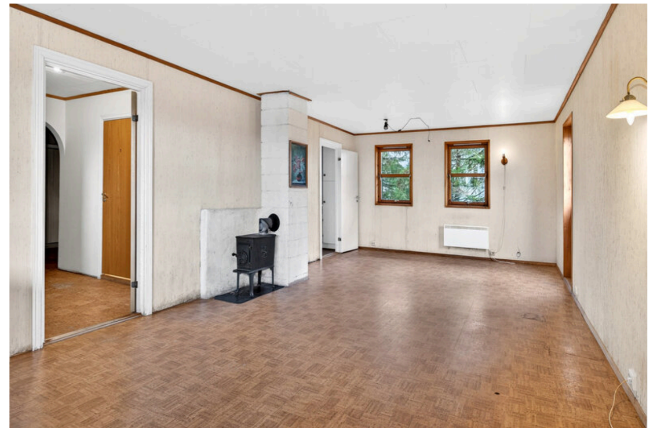
Samtlige rom i boligen har behov for omfattende modernisering og oppgradering.
