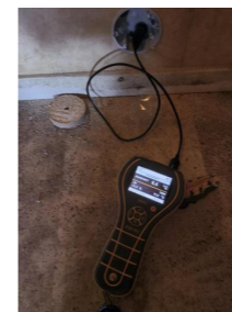
Kontroll i lukkede konstruksjoner - Fuktmåling
