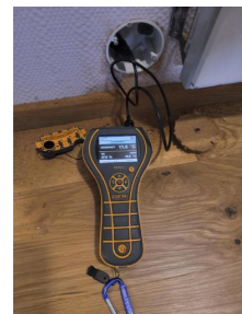
Utført kontroll i tilliggende konstruksjon - Fuktmåling
