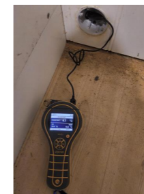
Kontroll i lukkede konstruksjoner - Fuktmåling
