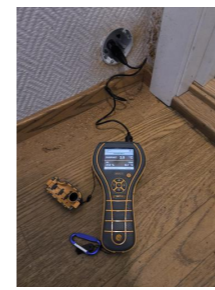
Utført kontroll i tilliggende konstruksjon - Fuktmåling
