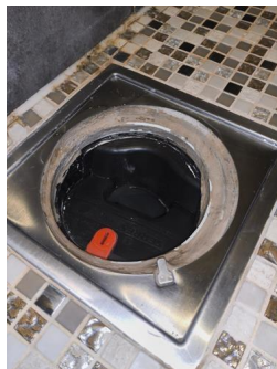
Tettesjiktets tilslutning til sluk - Sluk
