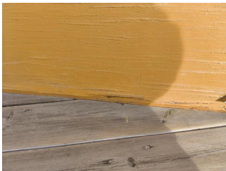
Overflatebehandling - Slitt overflatebehandling
