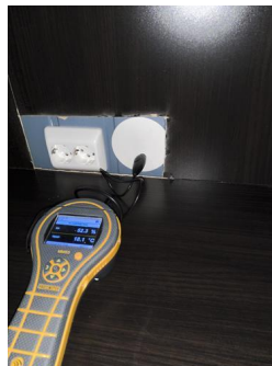
Utført kontroll i tilleggende konstruksjon - Fuktmåling
