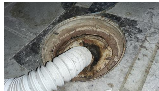
Tettesjiktets tilslutning til sluk - Sluk under badekar
