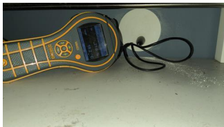
Utført kontroll i tiliggende konstruksjon - Fuktmåling
