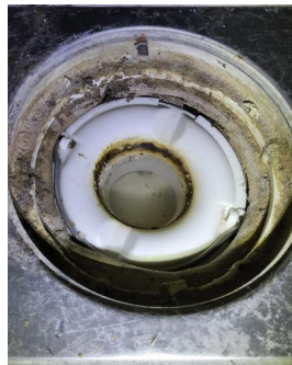
Tettesjiktets tilslutning til sluk - Sluk
