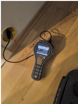
Utført kontroll i tilliggende konstruksjon - Fuktmåling
