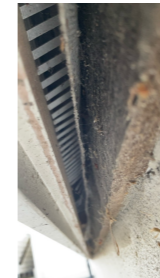
Lufting og museband på deler av vegger.
