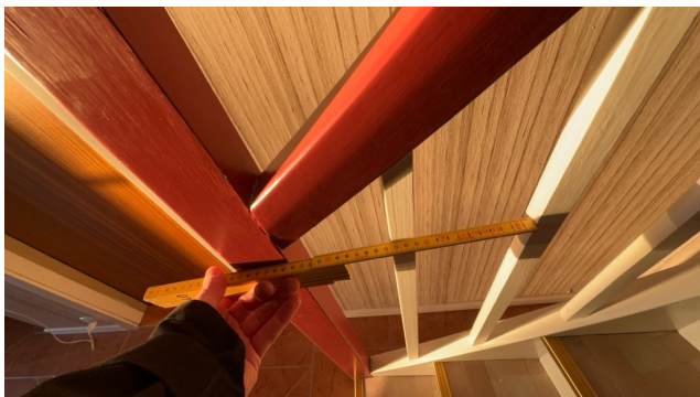
Åpning i rekkverk er mer en 10 cm
