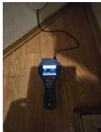
Utført kontroll i tiliggende konstruksjon - Fuktmåling vegg
