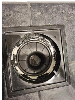
Tettesjiktets tilslutning til sluk - Sluk dusjsone
