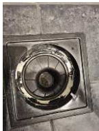
Tettesjiktets tilslutning til sluk - Sluk dusjsone
