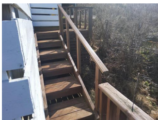
Rekkerkshøyde og lysåpninger - Rekkverk i trapp mellom terrasser.
