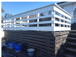
Rekkverkshøyde og lysåpninger - Rekkverk på terrasse ved anneks.
