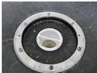
Tettesjiktets tilslutning til sluk - Sluk
