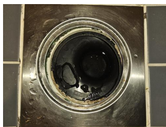
Tettesjiktets tilslutning til sluk - Sluk bad
