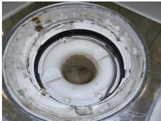
Tettesjiktets tilslutning til sluk - Sluk
