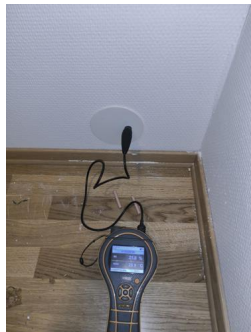
Utført kontroll i tilliggende konstruksjon - Fuktmåling
