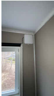
Montert mekanisk ventilasjonsanlegg med varmegjenvinner på to soverom i 2. etasje. Bør monteres fast strøm
