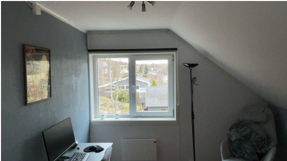
Mangler ventil på soverom 3
