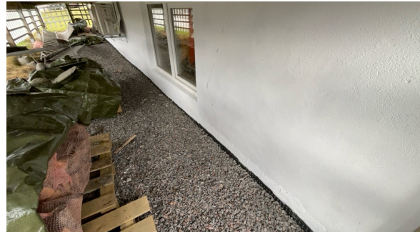
Ny drenering og synlig grunnmursplast på framvegg
