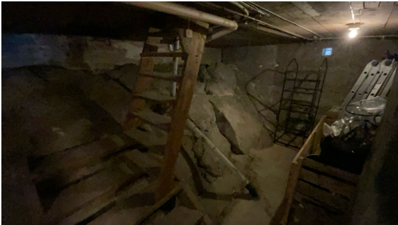
Indre del av kjeller har synlig berg/fjell
