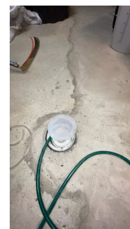
Ny sluk i gulv i kjeller er montert
