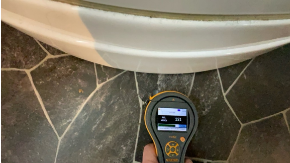
Fuktsøk er utført på gulv ved dusjkabinett. Ingen forhøyde fuktavvik er målt
