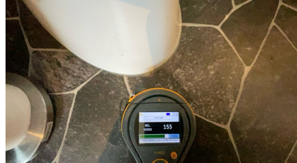
Fuktsøk er utført på gulv ved toalett. Ingen forhøyde fuktavvik er målt
