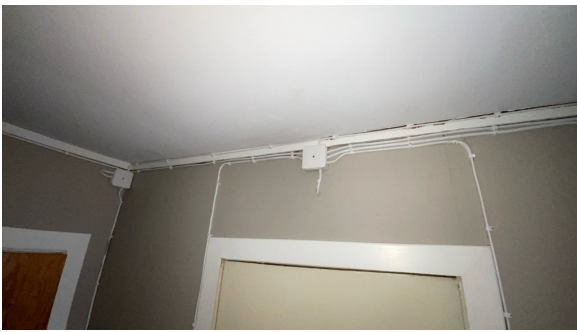
Installasjon i 2 etasje
