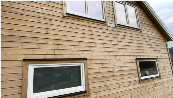
Vindu på soverom i 2. etasje, bad og stue 1. etasje
