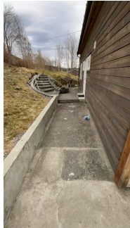
Det er svakt fall, og bortenfor trappen er det delvis fall mot boligen.
