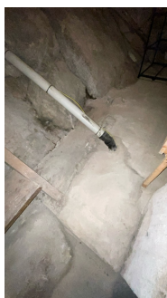
Nye avløpsrør som er støpt ned i kjeller
