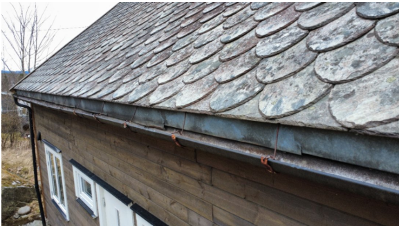
Eldre takrenne med beslag på oversiden
