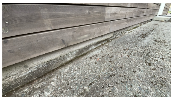
Liten del av grunnmur er synlig på oversiden
