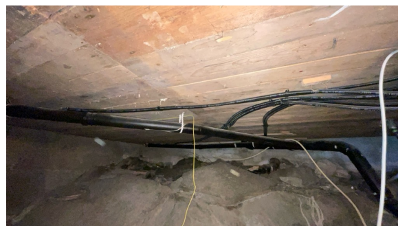
Åpne rør i kjeller
