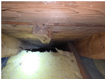
Luftespalte er tilgjengelig i skrå himlinger sett fra kryploft. Lite til ingen isolasjon i skrå takflater
