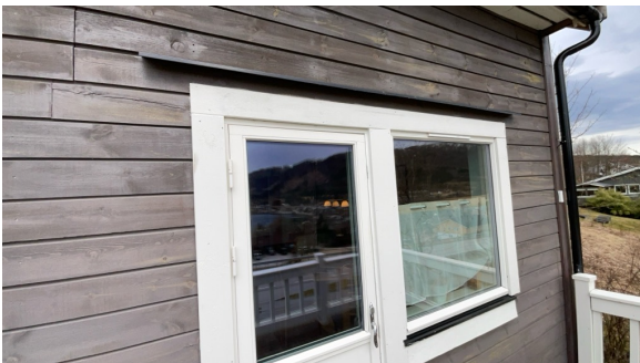
Vindu i stue
