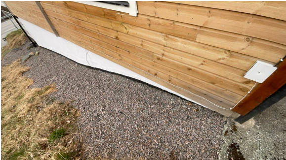
Ny drenering og synlig grunnmursplast på gavelvegg
