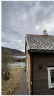
Vindsjikt på en side er montert med skrå som følge av takteking.
