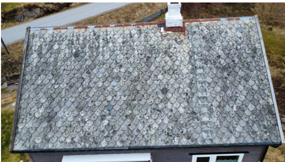
Vindsjikt på en side er montert med skrå som følge av takteking.
