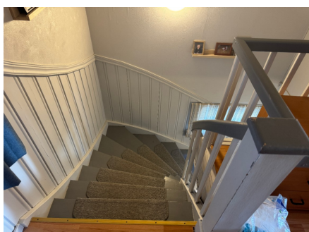
Trapp mellom 1. og 2. Etasje
