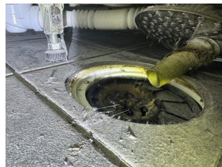
Sluk under kabinett der det ikke er observert indikasjoner på membran
