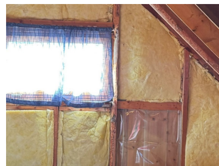
Plast mellom utv.panel og isolasjon
