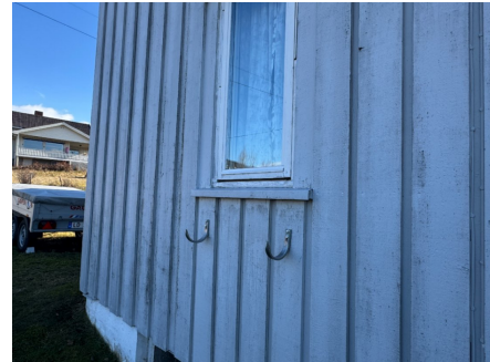
Slitt panel med en del svertesopp
