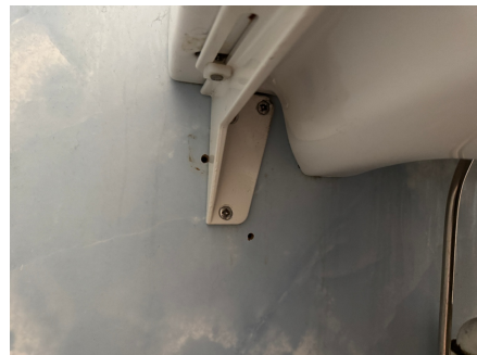
Hull i plater under servant som medfører at tettesjikt er brutt i våtsonen.
