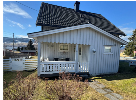
Terrasse ved inngang
