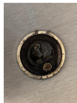
Hull i plater under servant som medfører at tettesjikt er brutt i våtsonen.
