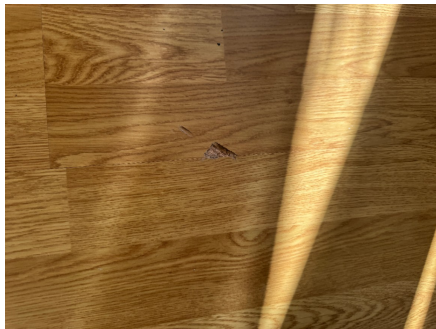
Skader i laminatgulv
