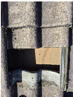
Undertak (inkluderer sløyfer, lekter og innfestninger) - Undertak opprinnelig del av boligen.
