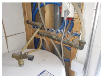
Fordelerskap og fordelerstammer - Fordelerstammer for rør-i-rør.
