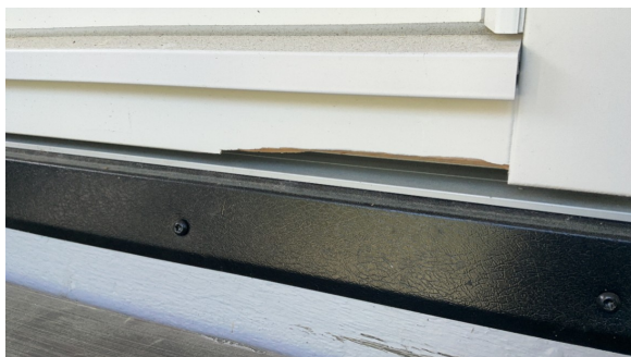
Skade i balkongdør i stue
