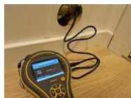
Utført kontroll i tiliggende konstruksjon - Fuktmåling bad.
