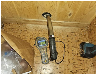
Kontroll i lukkede konstruksjoner - Fuktmåling
