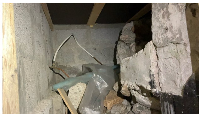
Kryptkeller under entré/bad.
