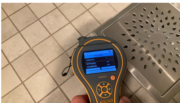
Gulv: Ved bruk av fuktindikator på utsatte steder registrerte jeg ikke forhøyde verdier.
