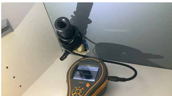
Fuktmåling med pigg mot våtrom: Det ble ikke målt forhøyde fuktverdier ved hulltaking på befaringstidspunktet.
