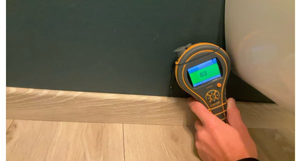
Vegg: Ved bruk av fuktindikator på utsatte steder registrerte jeg ingen unormale verdier.
