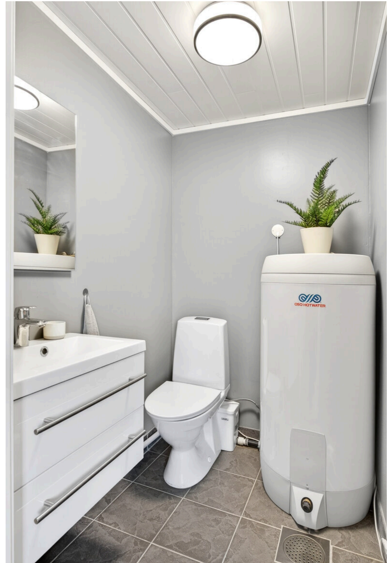
Toalettrom med fliser på gulv, vegghegt servantinredning og gulvstående toalett.
