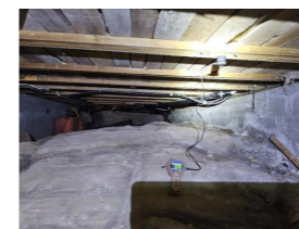
Stikktaking i treverk, fukt og fuktmålinger - Fuktmåling
