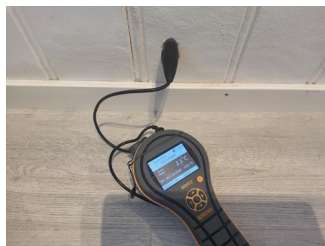
Utført kontroll i tilliggende konstruksjon - Fuktmåling
