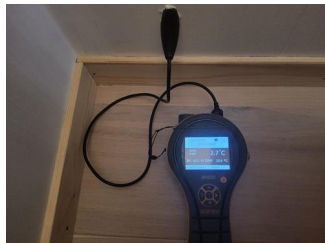
Utført kontroll i tilliggende konstruksjon - Fuktmåling
