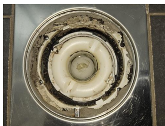
Tettesjiktets tilslutning til sluk - Sluk bad
