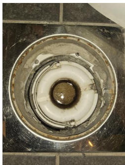
Tettesjiktets tilslutning til sluk - Sluk teknisk rom
