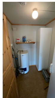
Innforet vegg mot terreng på teknisk rom/bod
