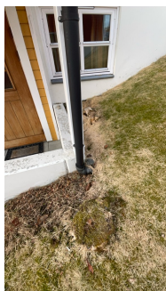
Taknedløp er ført til avløp i terreng
