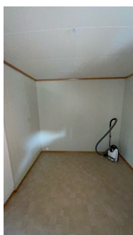
Innforet vegg mot terreng på soverom
