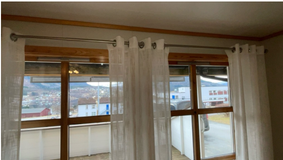
Ventiler i vindu
