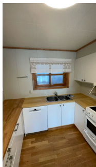
Innforet vegg mot terreng på kjøkken
