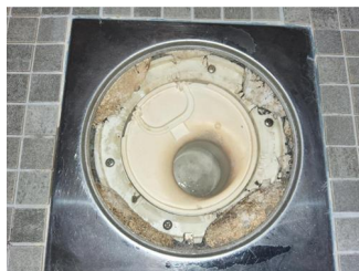
Tettesjiktets tilslutning til sluk - Sluk
