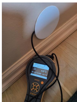
Utført kontroll i tilliggende konstruksjon - Fuktmåling
