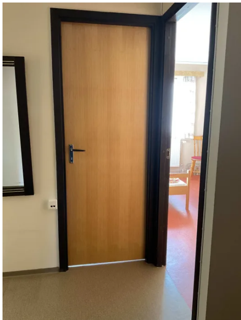
Innerdører fra opprinnelig byggeår med finerte dørblad
