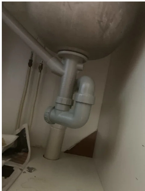
Synlige innvendige avløpsrør i PVC-plast
