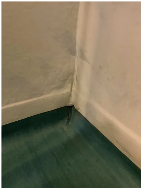
Tapet med limslipp
