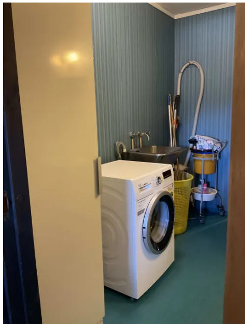
Baderom med opplegg for vaskemaskin
