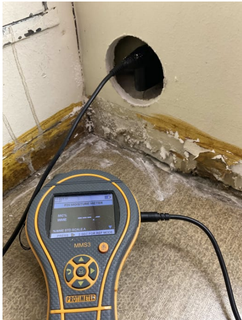
Fuktsøk med hultakning, ingen unormale verdier.
