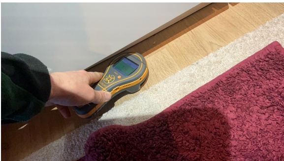
Enkle fuktsøk viste normale verdier.
