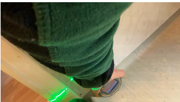
Enkle fuktsøk på baderomsplater viste forhøyde verdier.
