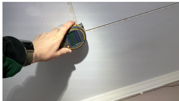
Fuktmerker i himling kjøkken 2. etasje, fuktsøk viste normale verdier.
