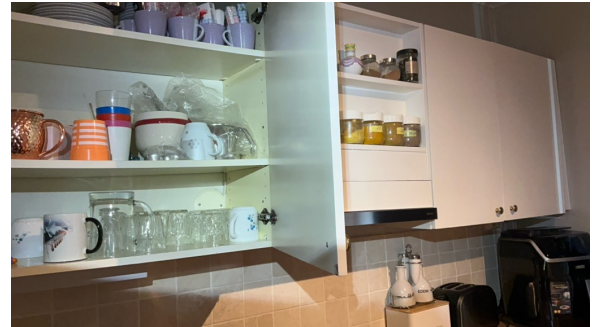
Eldre veggskap har enkelte merker, normal bruksslitasje. Noe behov for justering.
