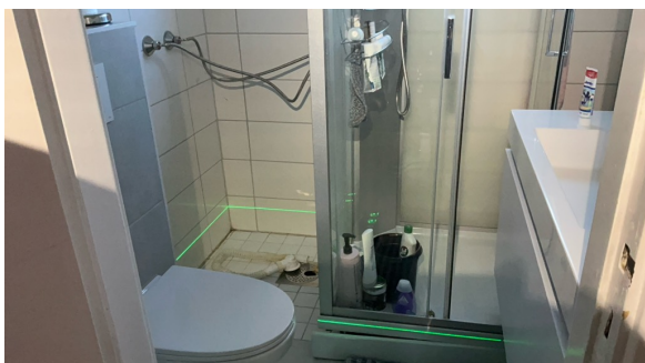
Oversiktsbilde av bad, leilighet mot mot nord.
