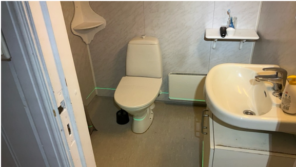
Oversiktsbilde av bad loftsetasje.
