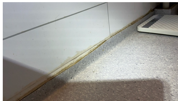
Ikke tett overgang mellom veggplater og gulvbelegg i våtsoner. Delvis manglende sokkelskinner.
