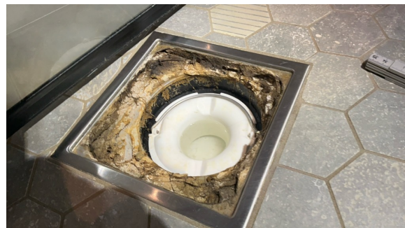
Kontroll av sluk.
