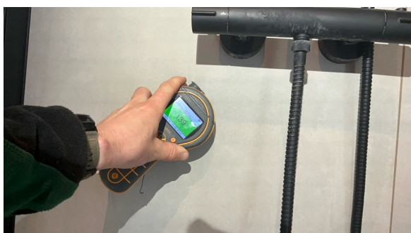
Enkle fuktsøk viste normale verdier.
