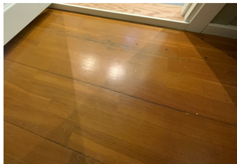
Eksempel på slitasje for gulvflater.
