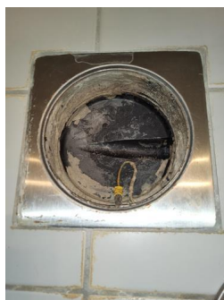
Tettesjiktets tilslutning til sluk - Hjelpesluk bad
