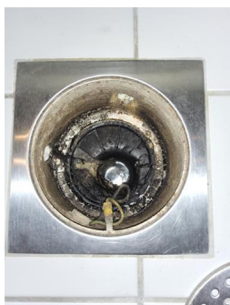
Tettesjiktets tilslutning til sluk - Sluk bad
