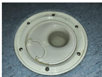
Overflate gulv - Sluk i bod
