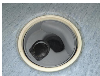
Tettesjiktets tilslutning til sluk - Sluk i dusj
