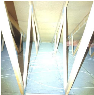
Inspeksjonsmulighet - Redusert luftutskiftning ved yttervegger
