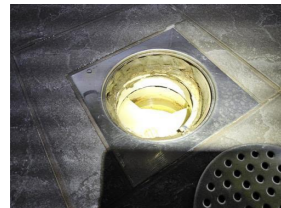
Tettesjiktets tilslutning til sluk - Sluk.
