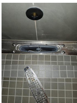
Tettesjiktets tilslutning til sluk - Sluk Baderom U.etasje.
