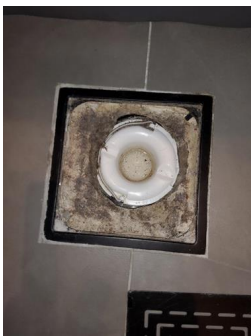
Tettesjiktets tilslutning til sluk - Sluk Vaskerom.
