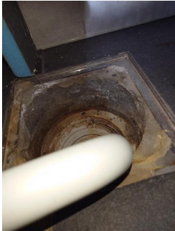
Tettesjiktets tilslutning til sluk - Sluk Baderom 2.etasje, under badekar.
