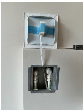
Til utekran. Lekkasjesensor montert.
