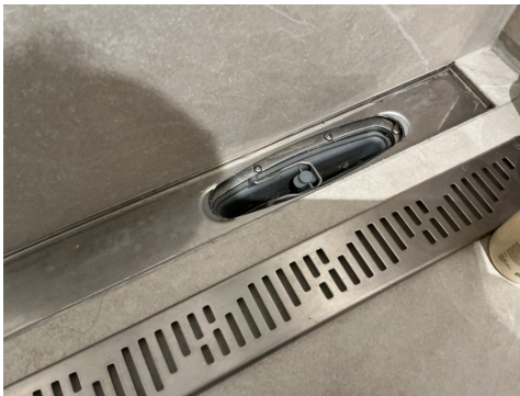
Slukrenne i dusjen
