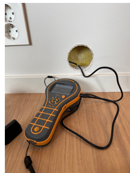
Fuktmåling i hulrom i veggen bak dusjen.
