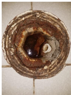
Tettesjiktets tilslutning til sluk - Sluk bad
