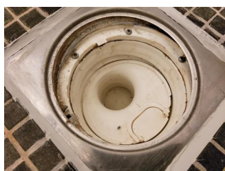
Tettesjiktets tilslutning til sluk - Sluk
