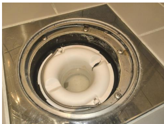
Tettesjiktets tilslutning til sluk - Sluk
