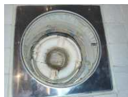
Tettesjiktets tilslutning til sluk - Sluk
