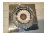
Tettesjiktets tilslutning til sluk - Sluk
