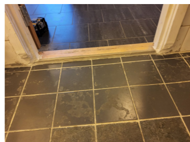
Lister rundt døra er skadet og fuget overalt.
