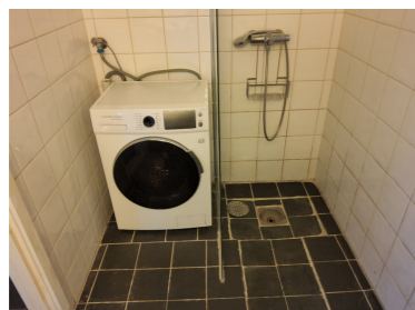
Fuger på gulvet er dårlig utført
