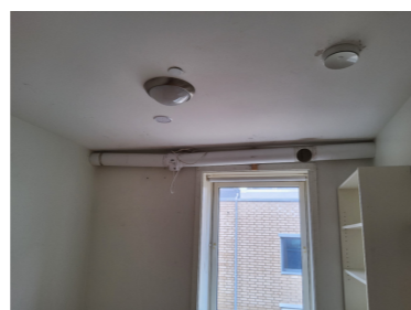
Ukjen founkjsjon ikke en del av byggets ventilasjon
