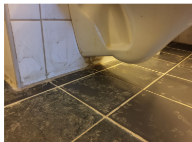
Fuger på gulvet er dårlig utført
