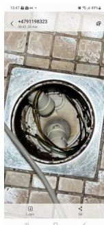
Vanntett sjikt / membran i gulv og vegger - Hovedsluk bad.
