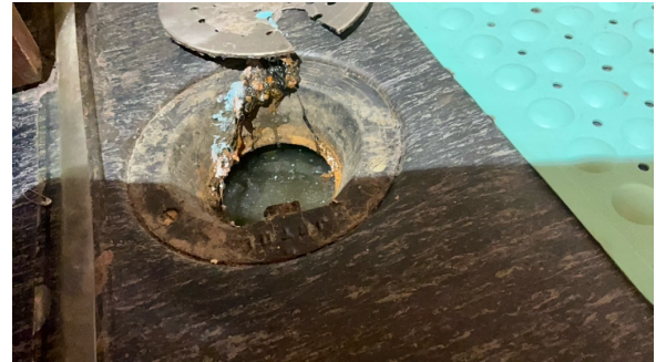
Kontroll av sluk.
