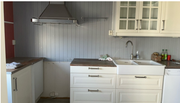
Oversiktsbilde av kjøkkenet.
