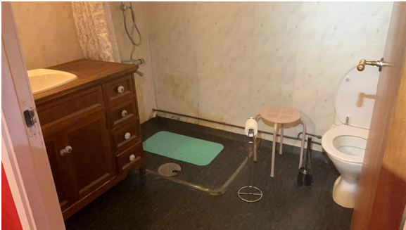
Oversiktsbilde av bad.
