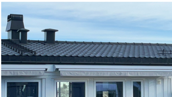
Bulker på takteking sett fra bakkenivå.
