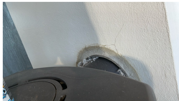
Utett rørgjennomføring i pipe. Selger opplyser at dette skal utbedres i etterkant av befaringen.
