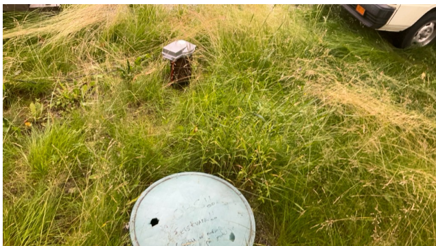
vannbrønn ved adkomst
