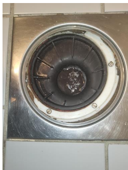
Tettesjiktets tilslutning til sluk - Sluk bad
