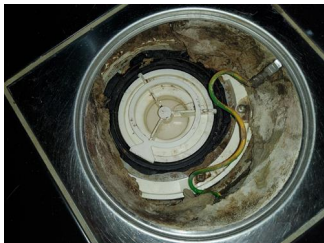
Tettesjiktets tilslutning til sluk - Sluk
